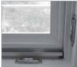
Inklemhor in houten kozijn met aluminium onderstrip
