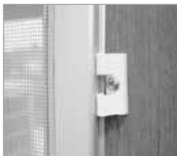
De voorzethor kan met clips op het kozijn geklikt worden.
